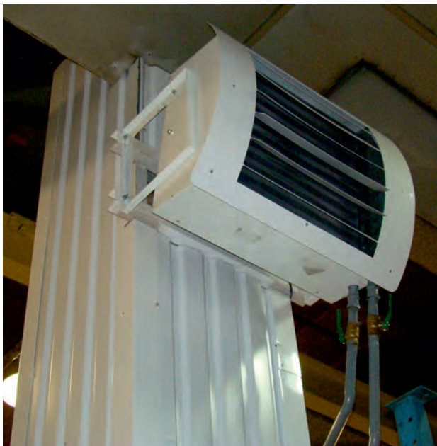
Монтаж на колоне AVO-62
