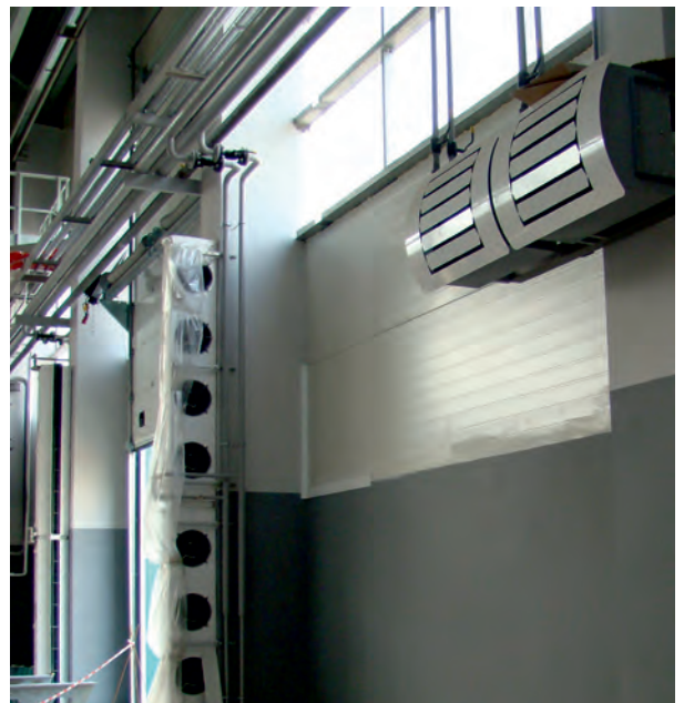
Монтаж тепловые завесы AG-424(2шт) и AVO-62(2шт)
